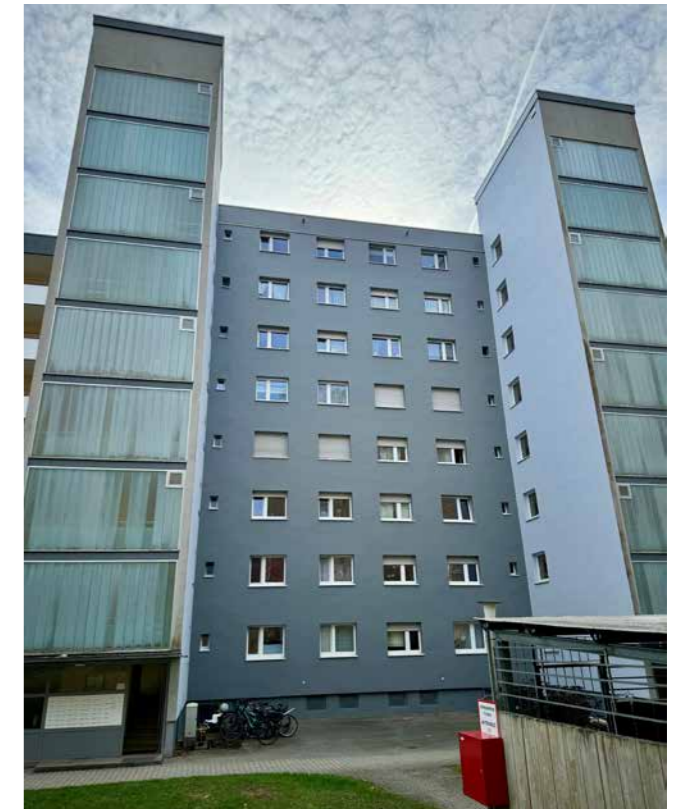
Nach den Instandhaltungsmaßnahmen erstrahlt die Fassade am „alten“ Pfeiferhölzle wieder in neuem Glanz. Foto: Michael Moser
